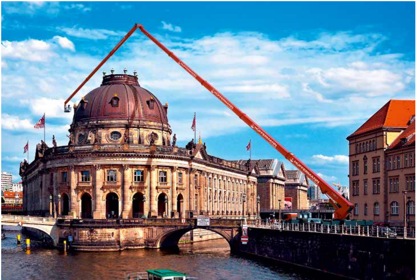
Mit dem Ruthmann-Steiger kann Hüffermann eine Arbeitshöhe von bis zu 90 Metern anbieten. Der Steiger punktet durch hohe Flexibilität und Beweglichkeit – in diesem Fall bei Sanierungsarbeiten.
