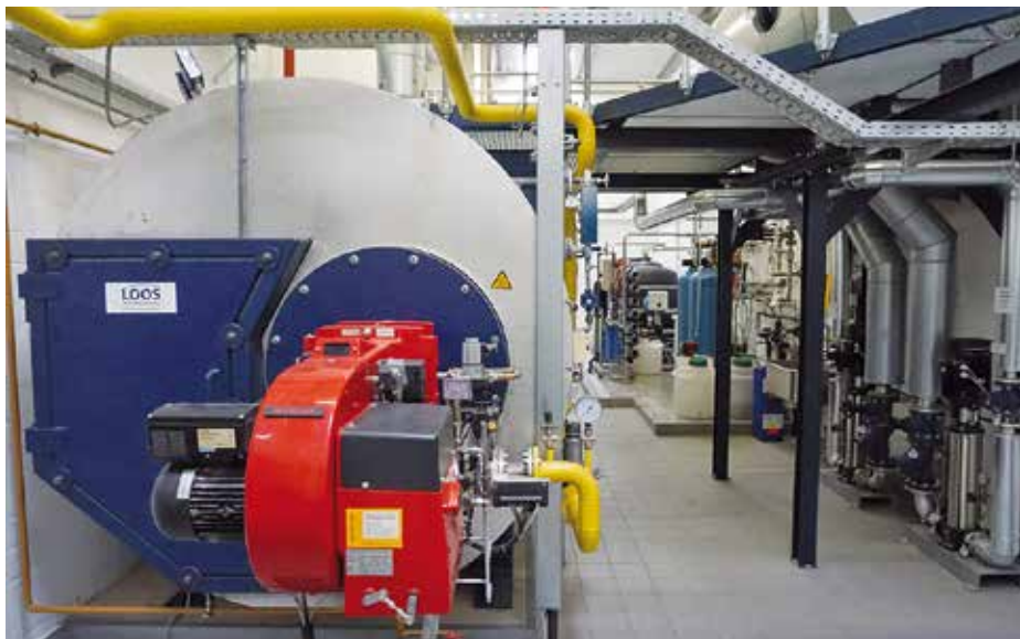
Dampfkessel mit einer Dampfleistung von 4.000 Kilogramm pro Stunde.
