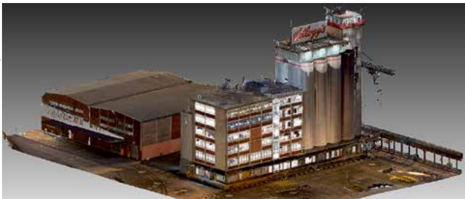
Die markante ehemalige Cornflakes-Fabrik von Kellogg's an der Weser haben Volker Platen und sein Team gescannt – hier eine fotorealistische Punktwolke. Demnächst soll das Gebäude zu einem Hotel umgebaut werden.
