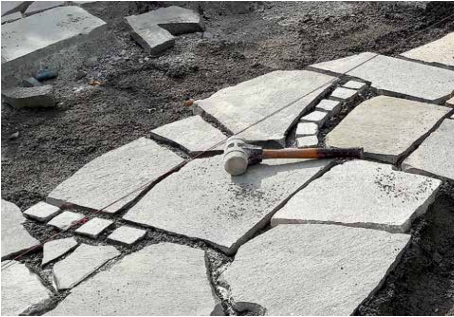
Naturstein im Privatgarten: Verbindende Gartenwege und Terrassen aus Porphyry-Polygonalplatten in Kombination mit Porphyry-Kleinpflaster, farbig sortiert abgestimmt auf das Bauvorhaben. Insgesamt wurden 260 Quadratmeter Platten und Kleinpflaster auf Drainagebeton verlegt.
