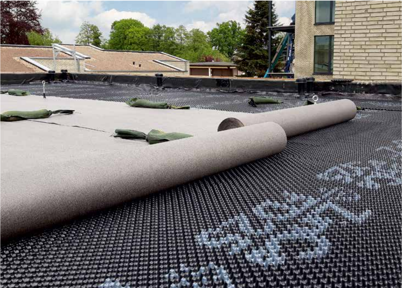
Bild oben: Marissa Ferienpark am Dümmer See. Teilfläche: Speicherschutzmatte, Drainageelement und Filtervlies. Im Hintergrund Ferienhäuser, mit fertiggestellten und für die Sprosseneinsaat vorbereiteten Dachflächen mit Kiesrandstreifen.
