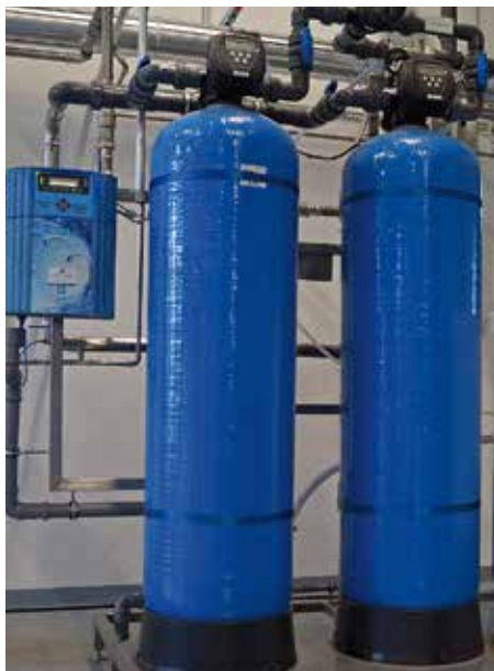
Enthärtungsanlage mit einer Nennkapazität von 800 \text{ m}^3 \times \text{° dH} .
