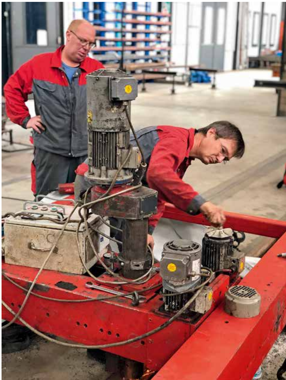
„Kleine Instandsetzungsarbeit“ am Fräsrahmen während eines Einsatzes in der Schweiz.
