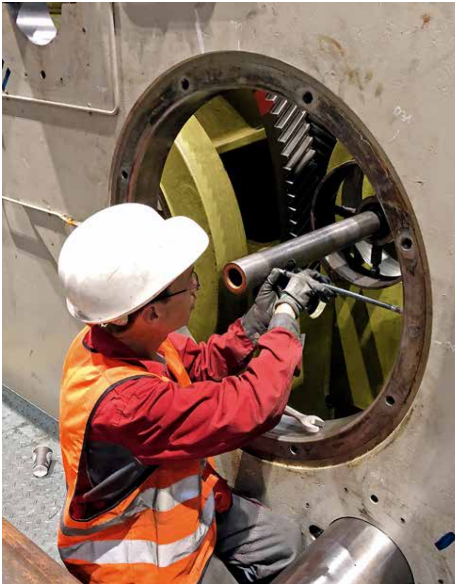
Einrichtungsarbeiten an einer Industriepresse mittels Innenmessschraube.
